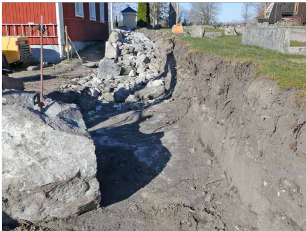
Figur 8. Berg i dagen synligt direkt under muren. De påförda massorna på kyrkogården är tydliga som ett mörkare lager i den övre delen av schaktkanten. Foto mot SV, Robin Lucas, Upplandsmuseet.
