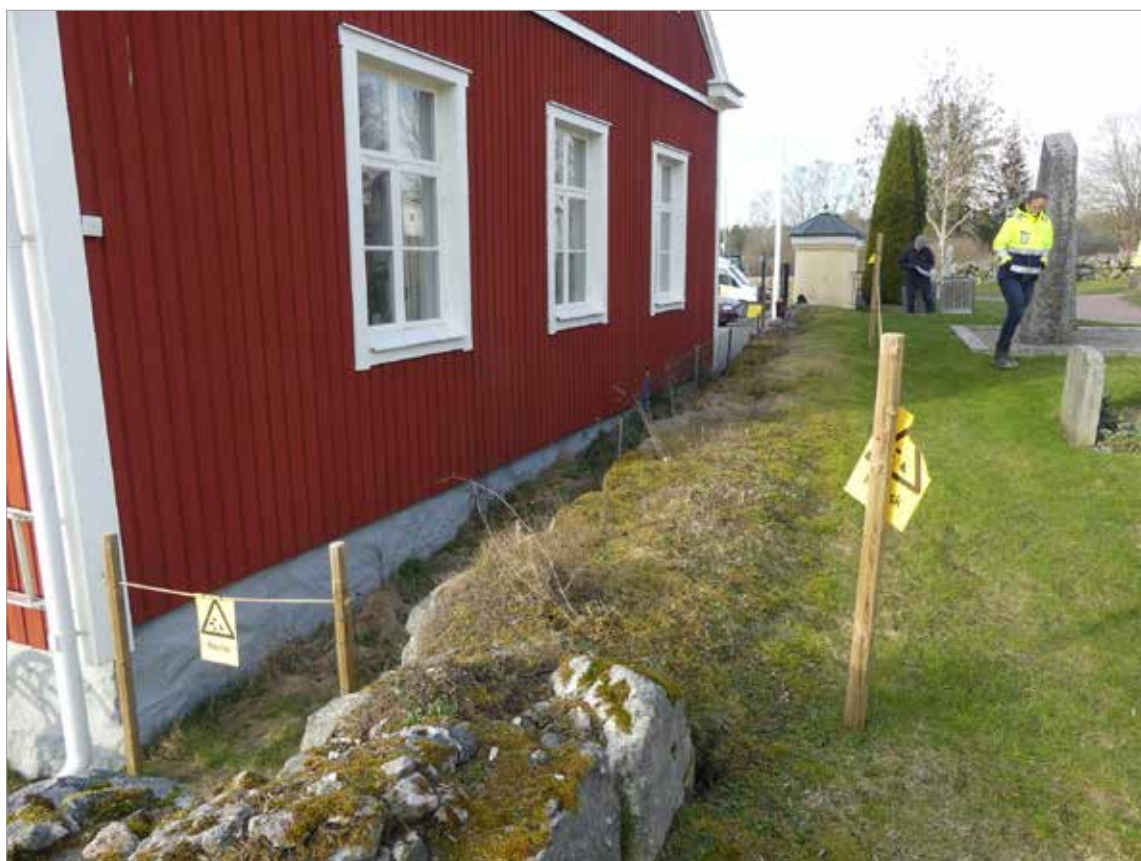
Figur 7. Den västra delen av muren innan arbetet inleddes. Ann-Sofie Hansson från Enköpings pastorat (i varseljacka) går på de massor som påförts på kyrkogården. Foto mot SV, Robin Lucas, Upplandsmuseet.
