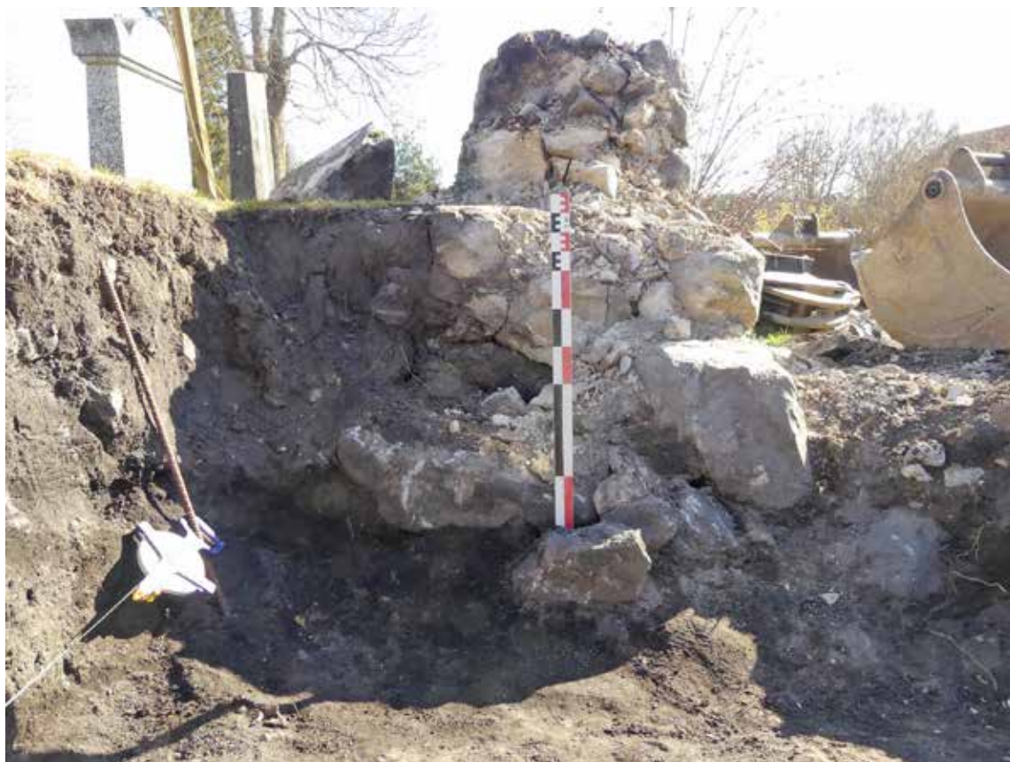
Figur 6. Tvärsnitt genom muren med konstruktionen tydlig: en yttre skalmur och en inre fyllning av småsten, tegel och kalkbruk. I bildens undre del syns kulturlagret som muren delvis var anlagd på. Foto mot NÖ, Robin Lucas, Upplandsmuseet.
