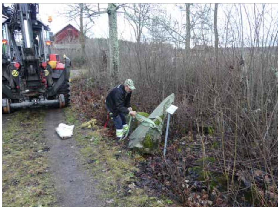
Figur 64. Gunnar Söder, grävmaskinist, förbereder för att lyfta runstenen U492.
