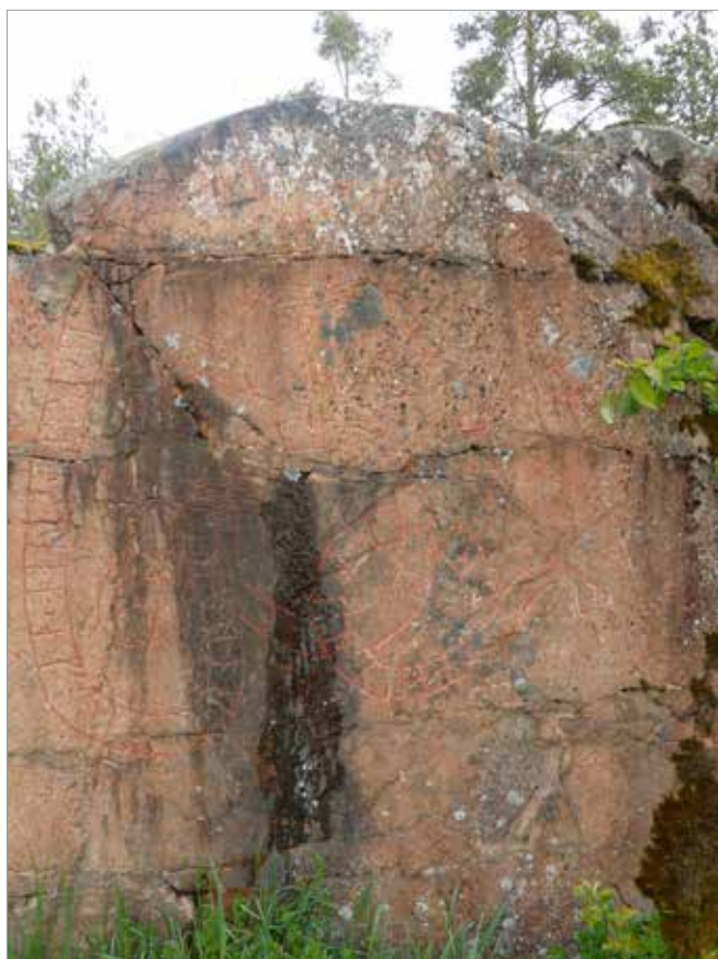
Figur 74. U598 med vatten som rinner ut från sprickor.
