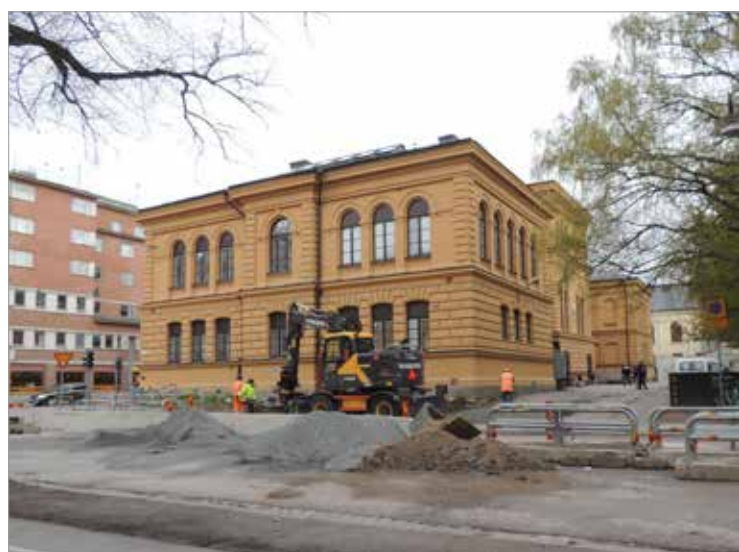
Figur 25 (till vänster). Arbetet med schakt 7 vid skolan i kvarteret Balder påbörjas. Foto mot nordväst, Linda Qviström/Upplandsmuseet.
