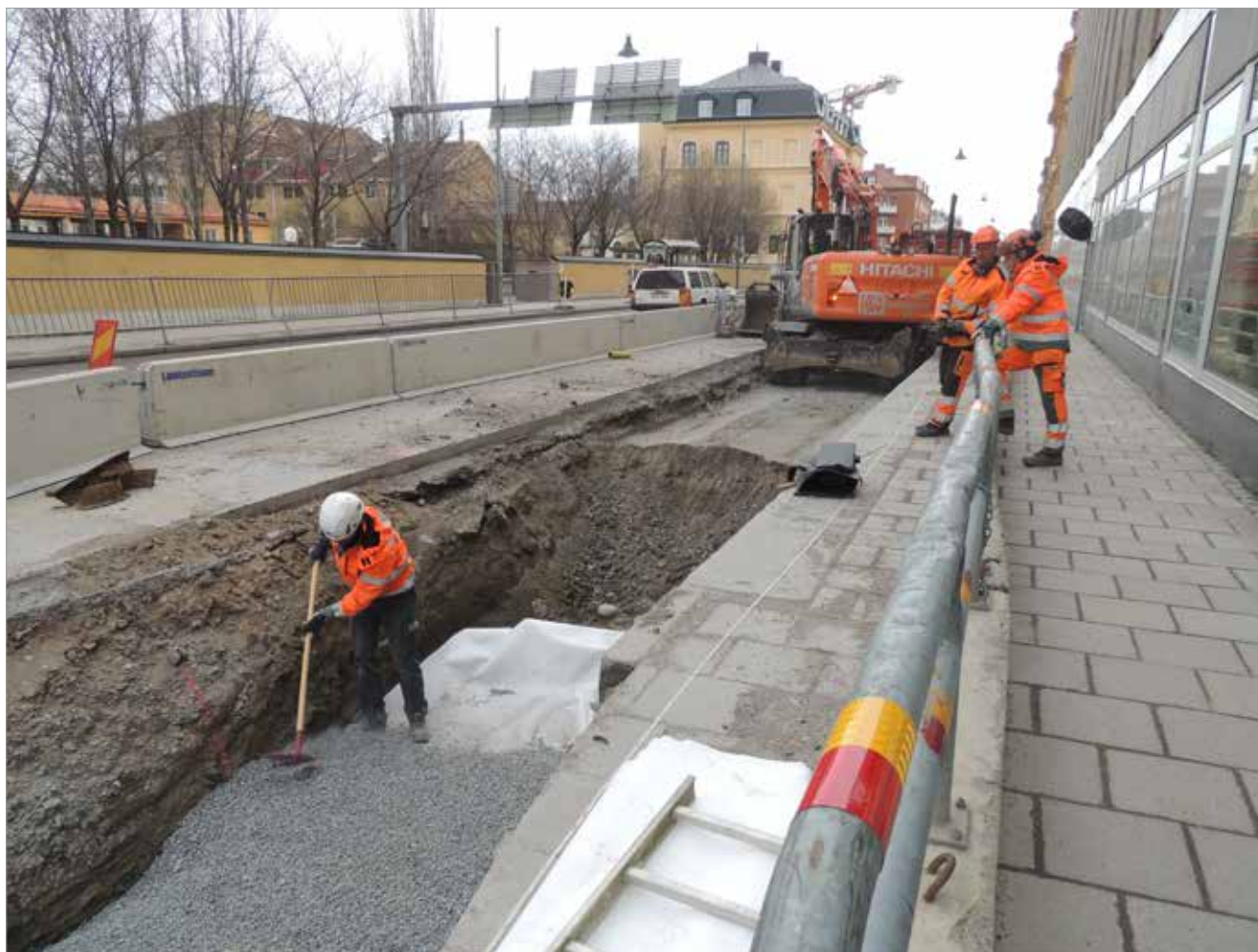
Figur 41. Schaktning längs Kungsgatan, schakt 4. Foto mot sydöst, Linda Qviström/Upplandsmuseet.
