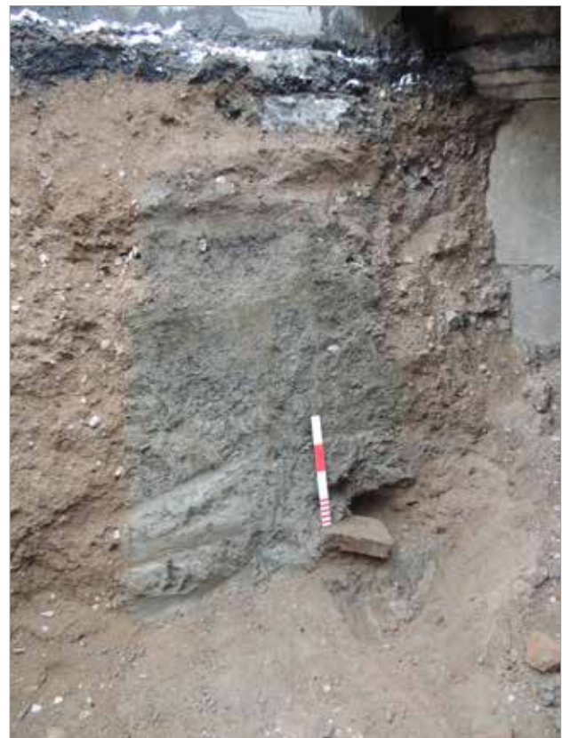
Figur 31a (till vänster). Avloppsledning (A1, schakt 5) av tegel i korsningen mellan S:t Olofsgatan och Kungsgatan. Foto från ovan, Linda Qviström/Upplandsmuseet.
