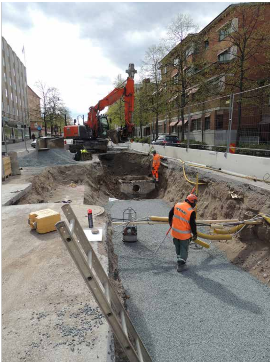
Figur 35. Östra delen av schakt 8. I bildens vänstra kant syns betongkulverten som hör till den fjärrvärmeledning som fortfarande var i bruk. Den äldre fjärrvärmeledningen har löpt i samma sträckning som det nuvarande schaktet. Betong-brunnen som syns mitt i schaktet, efter den grusade ytan, hör till denna generation av fjärrvärmeledning. Foto mot syd-väst, Linda Qviström/Upplandsmuseet.
