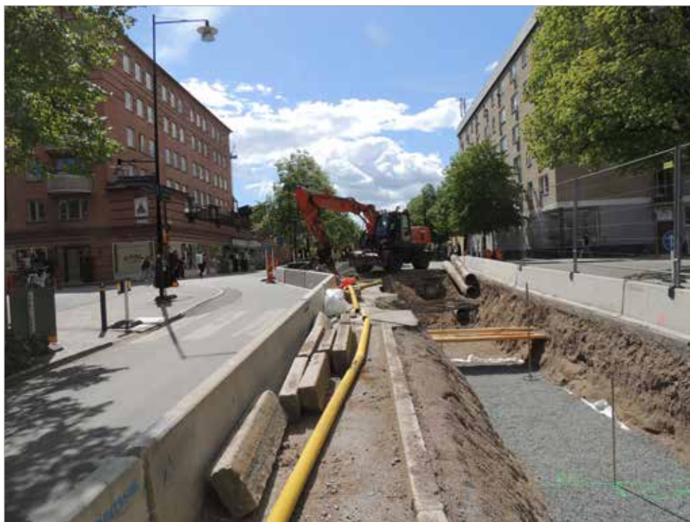
Figur 36. Schakt 8. Grävmaskinen står i korsningen mellan S:t Olofsgatan och Dragarbrunnsgatan. Foto mot sydväst, Linda Qviström/Upplandsmuseet.
