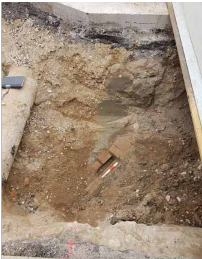
Figur 31a (till vänster). Avloppsledning (A1, schakt 5) av tegel i korsningen mellan S:t Olofsgatan och Kungsgatan. Foto från ovan, Linda Qviström/Upplandsmuseet.
