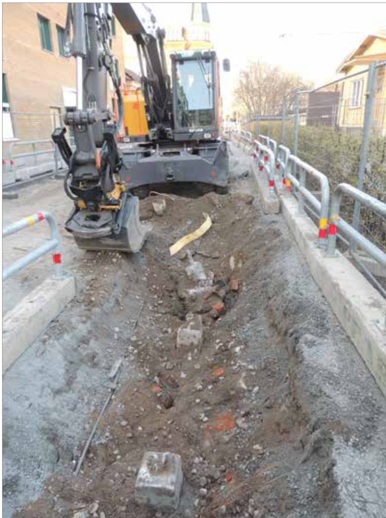
Figur 74. Schakt 3, schaktning längs norra spontkanten, från ca 42 m och västerut. Här fanns fyra betongplintar med fastgjutna metallrör, troligen från det cykelställ som anas till höger på bilden från 1948 (figur 76). Foto mot sydväst, Linda Qviström/Upplandsmuseet
