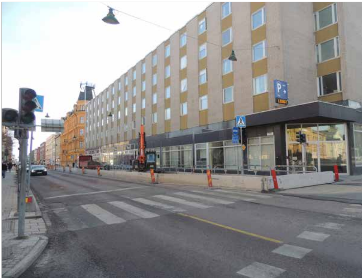
Figur 55. Samma sträcka av Kungsgatan 2020, under pågående schaktningsarbete. Foto mot sydöst, Linda Qviström/Upplandsmuseet.
