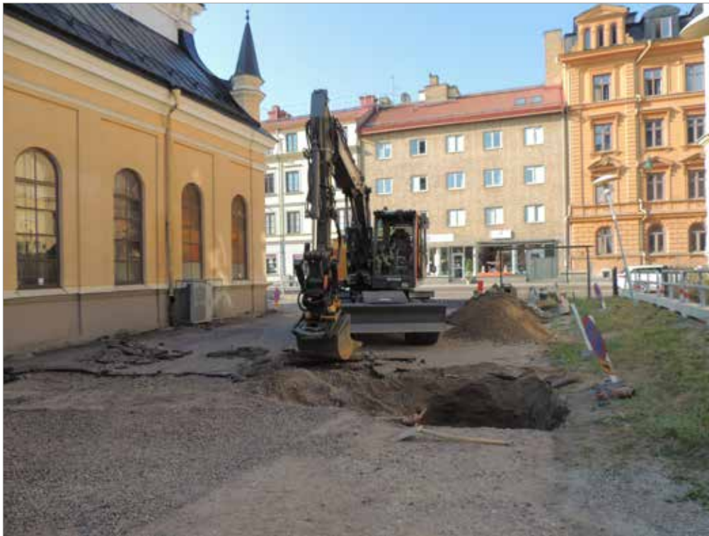
Figur 105. Schaktningar för dagvattenbrunn vid S:t Johannes kyrka i kvarteret Gimle. Foto mot väster Linda Qviström/Upplandsmuseet.
