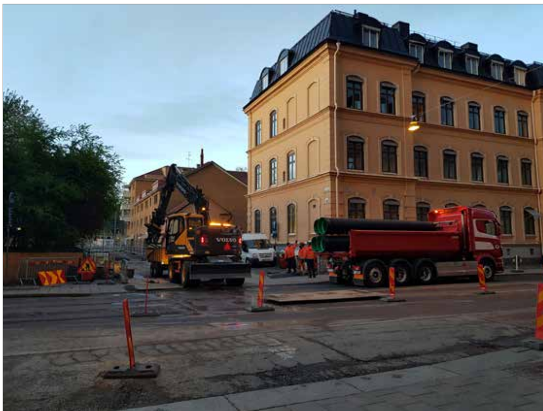
Figur 53. Schakt 9. Kvällsgrävningen tvärs över Kungsgatan är inledd. Foto mot nordöst, Linda Qviström/Upplandsmuseet.
