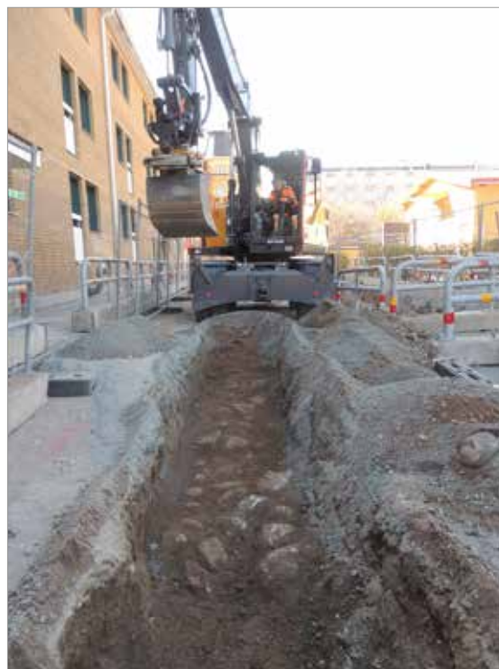
Figur 70. Schakt 3, A6, framtagen i samband med schaktning längs södra spontlinjen vid ca 20 m. Foto mot sydväst, Linda Qviström/Upplandsmuseet.
