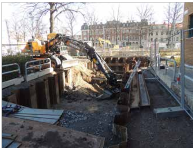
Figur 60. Östra delen av schakt 3 efter att området djupschaktats och spont slagits ned. Foto mot nordöst, Linda Qviström/Upplandsmuseet.
