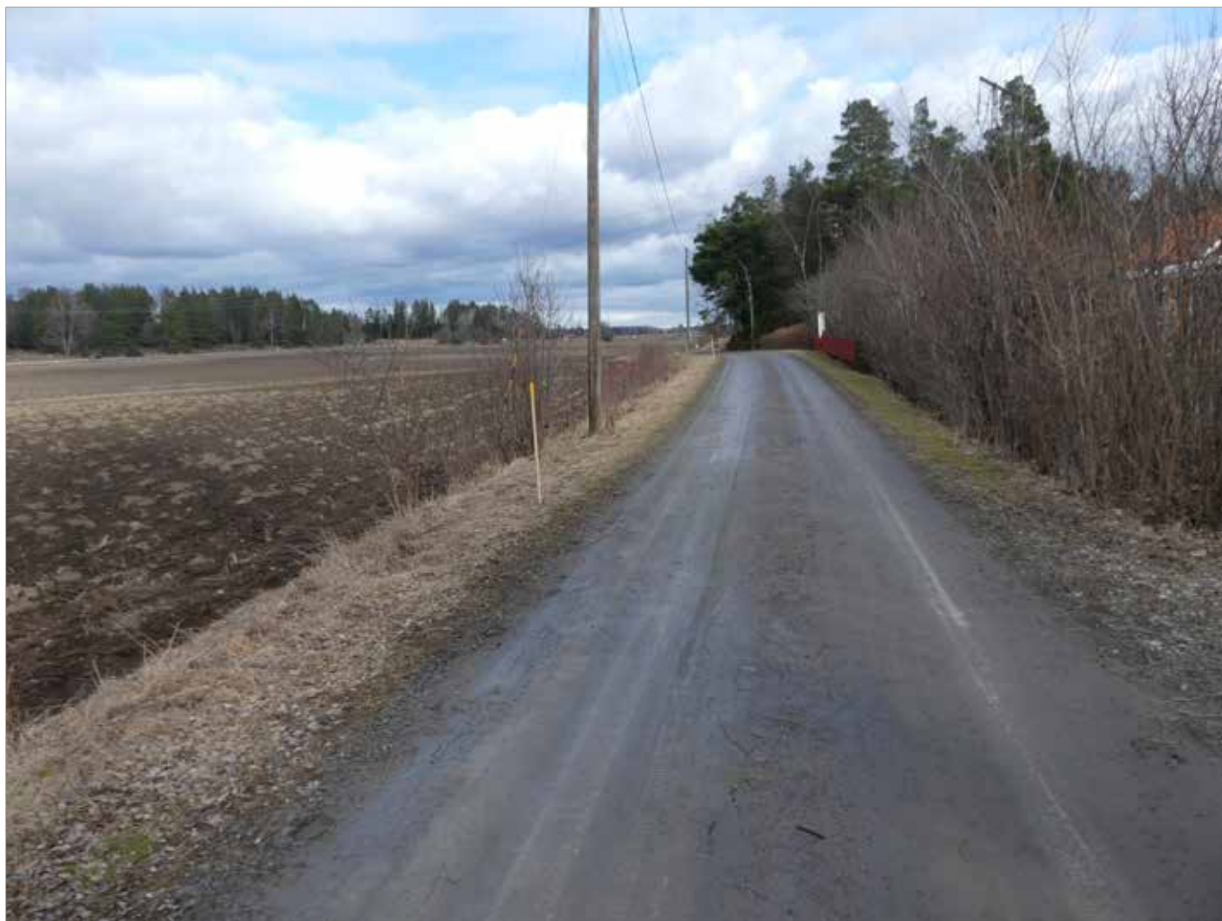
Figur 15. Inom delsträcka 6 skulle elkabeln anläggas i den västra delen av vägbank och invid befintlig ledning, varför ingen schaktningsövervakning gjordes. Foto mot nordöst.
