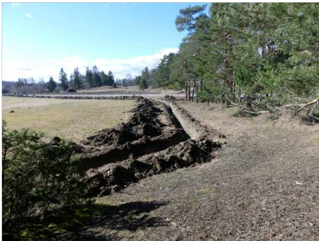
Figur 16. I den södra delen av delsträcka 7 grävdes schaktet i tidigare åkermark. Foto mot sydväst.
