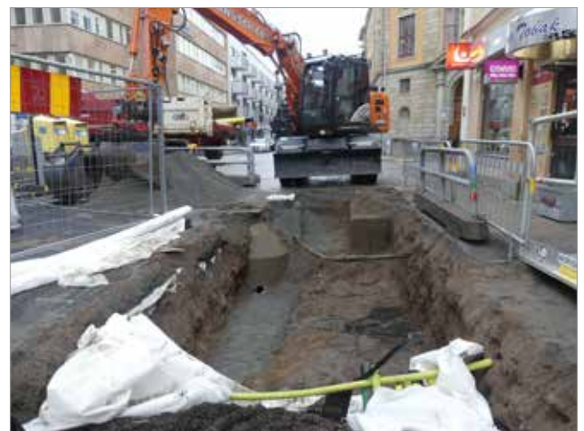
Figur 53. Läget för schakt 14. Foto mot S, Malin Lucas.
