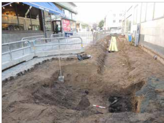
Figur 56. Läget för schakt 15. Foto mot Ö, Linda Qviström
