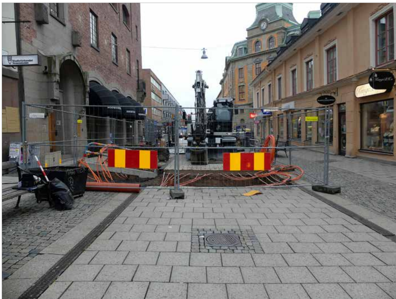
Figur 47. Läget för schakt 11. Foto mot S, Malin Lucas.
