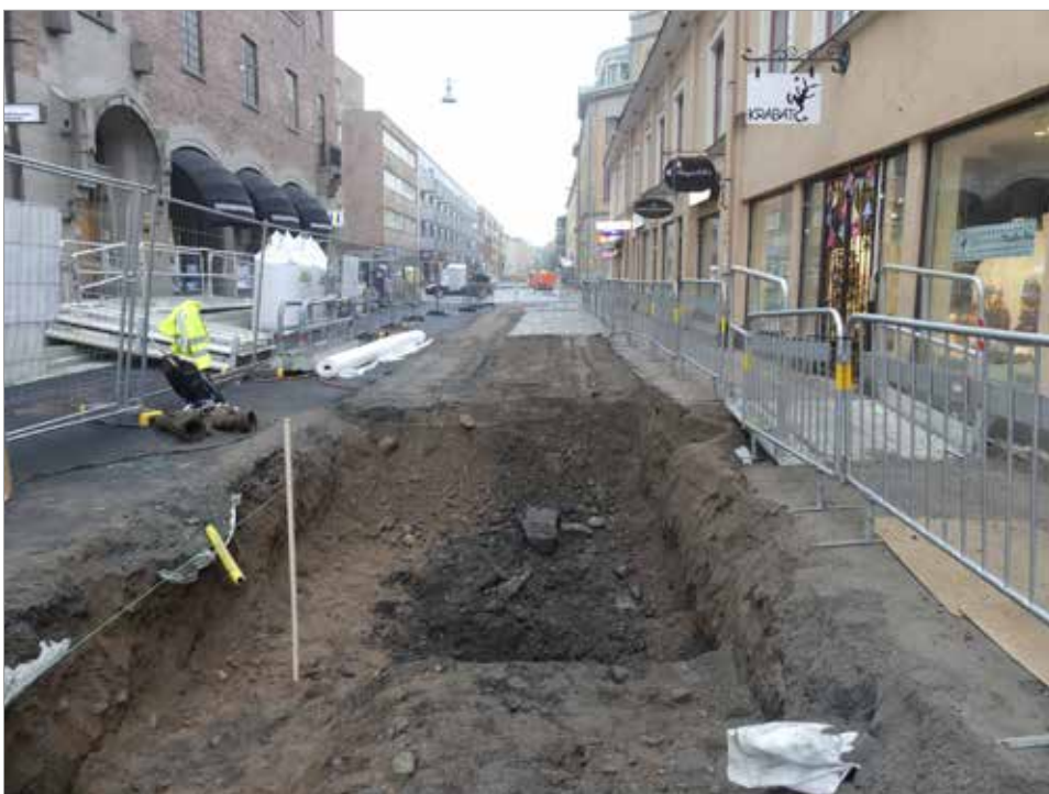
Figur 46. Läget för schakt 10. Foto mot S, Malin Lucas.
