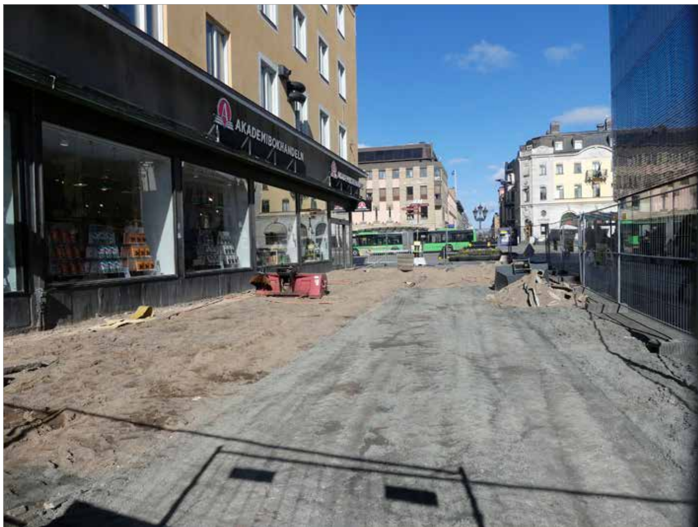
Figur 5. Delar av gågatan med ytskiktet borttaget. Foto mot N., Malin Lucas
