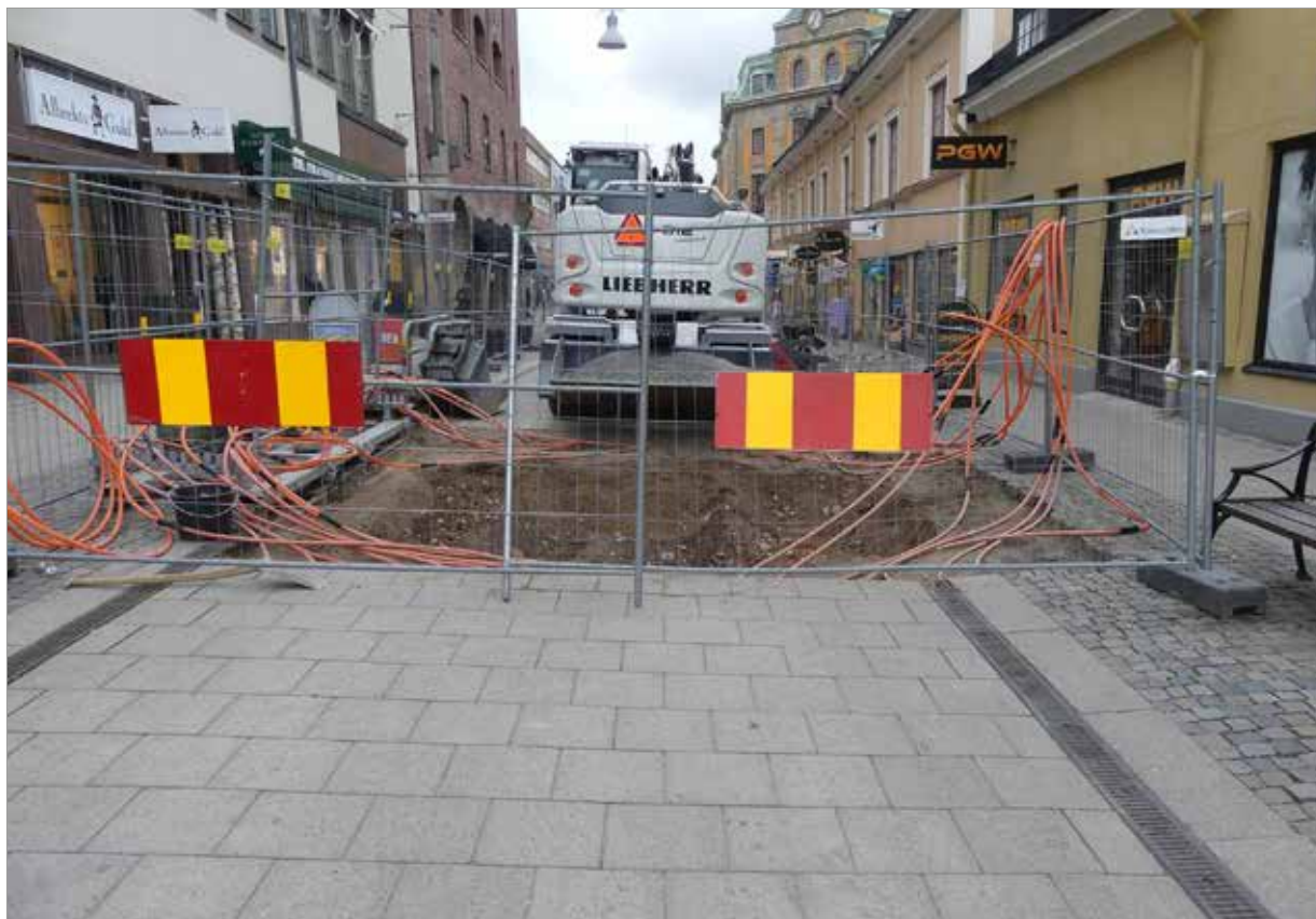
Figur 43. Läget för schakt 9. Foto mot S, Anna Ölund
