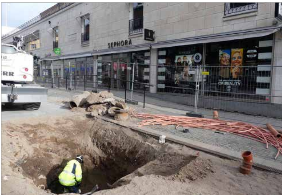
Figur 39. Läget för schakt 8. Foto mot N, Anna Ölund.
