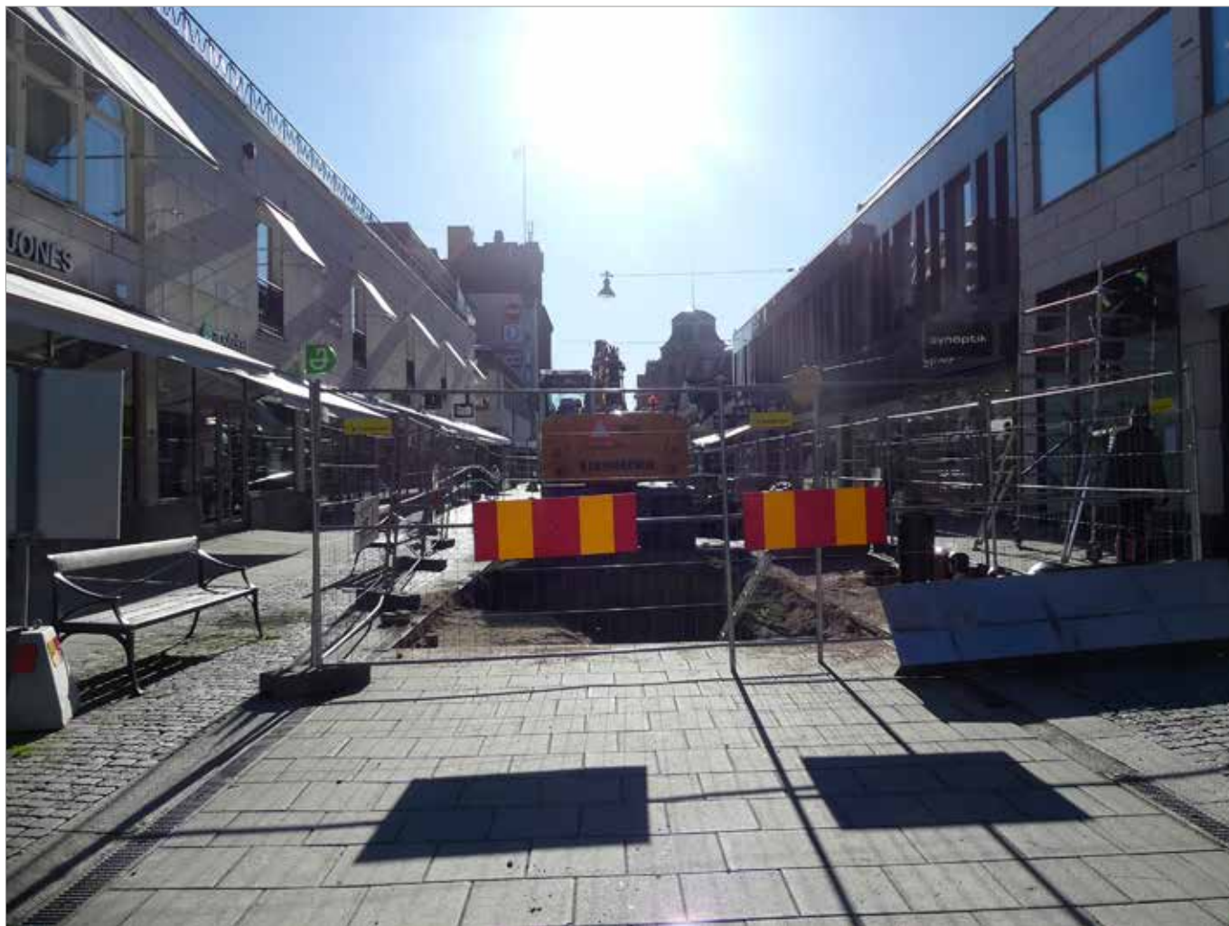
Figur 36. Läget för schakt 7. Foto mot S, Malin Lucas.
