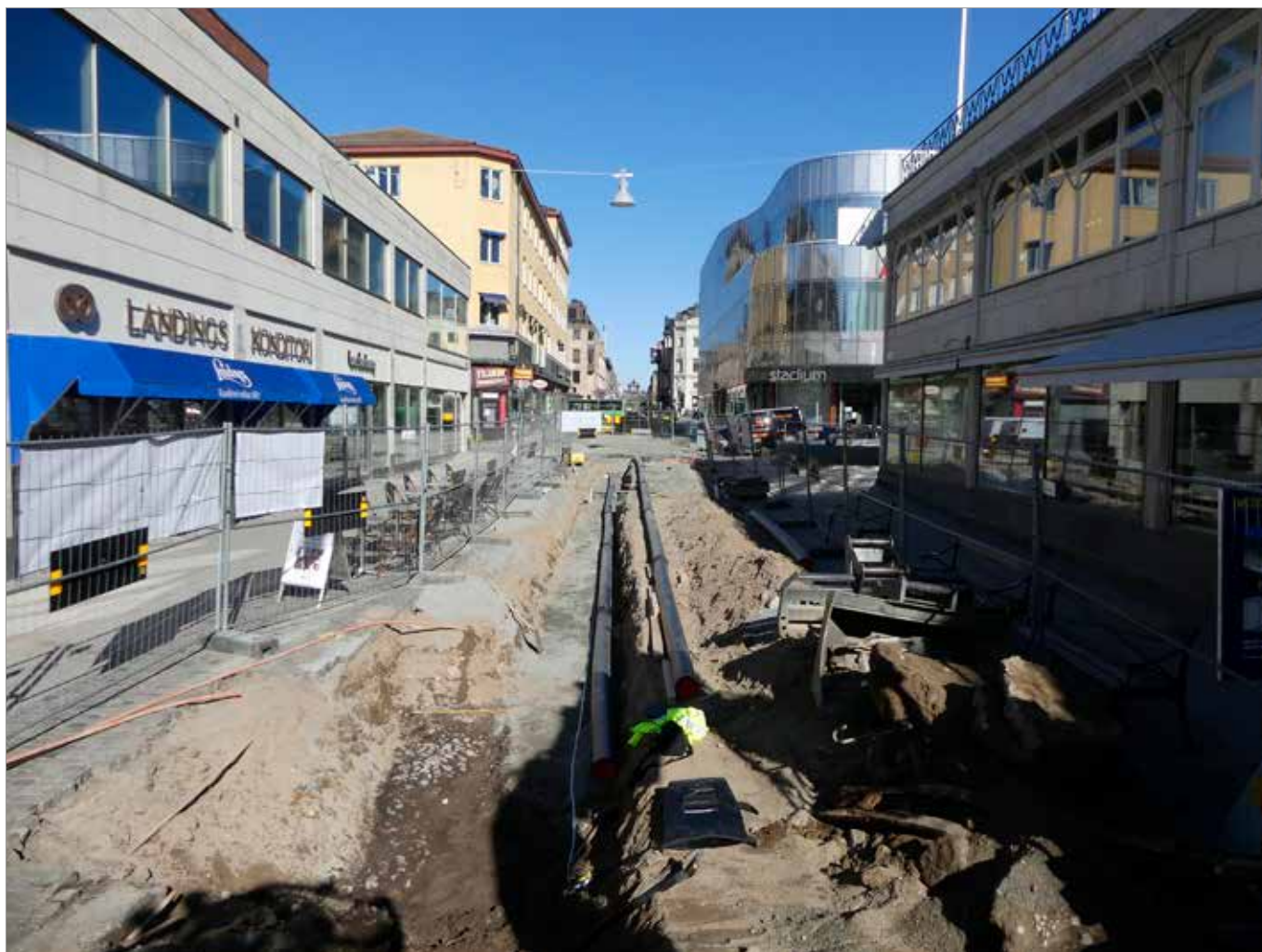
Figur 29. Läget för schakt 6. Foto mot S, Malin Lucas.
