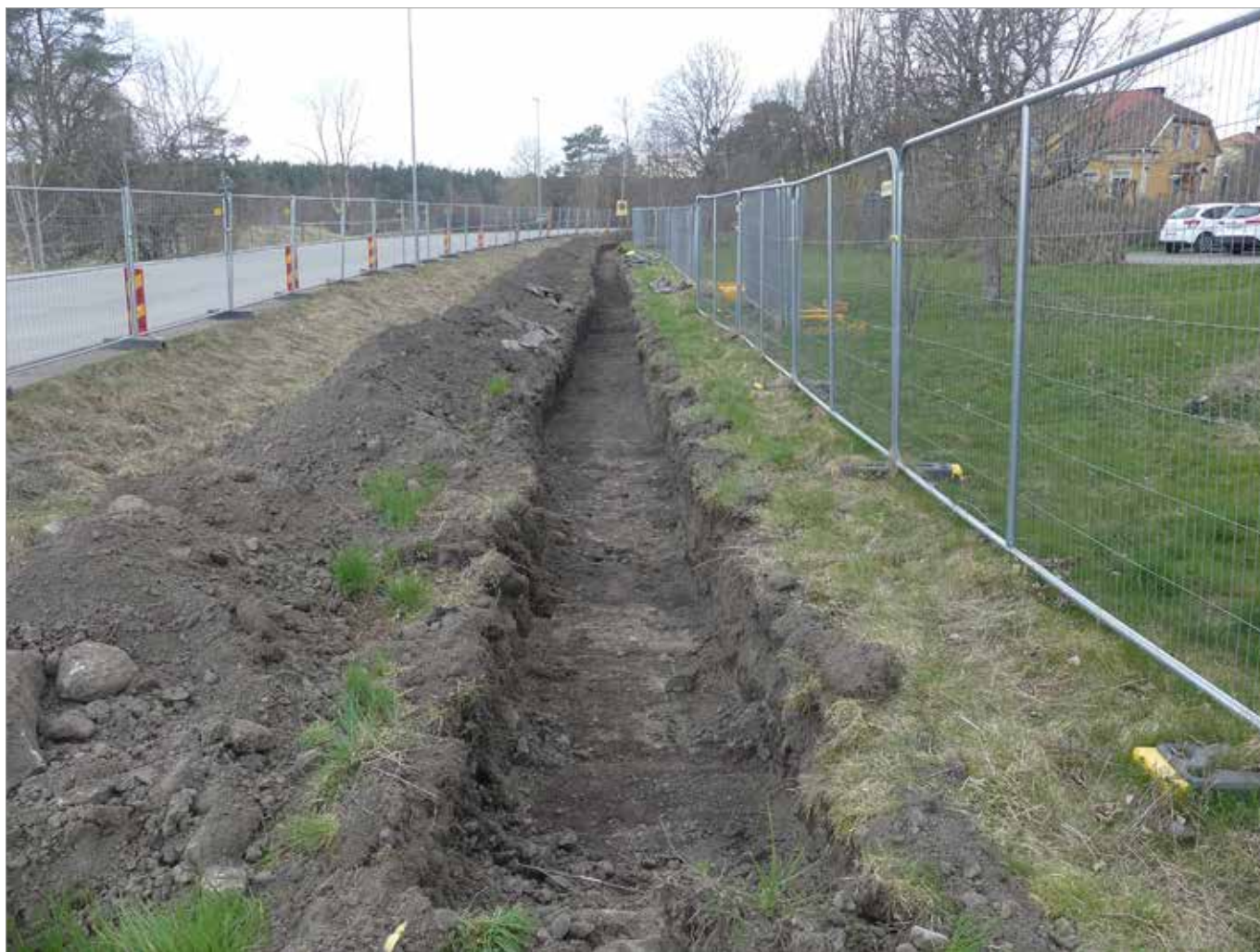
Figur 11. Schaktet i den östra delen av L1941:2286 låg mellan dike och staket. Foto mot sydväst, Malin Lucas, Upplandsmuseet.
