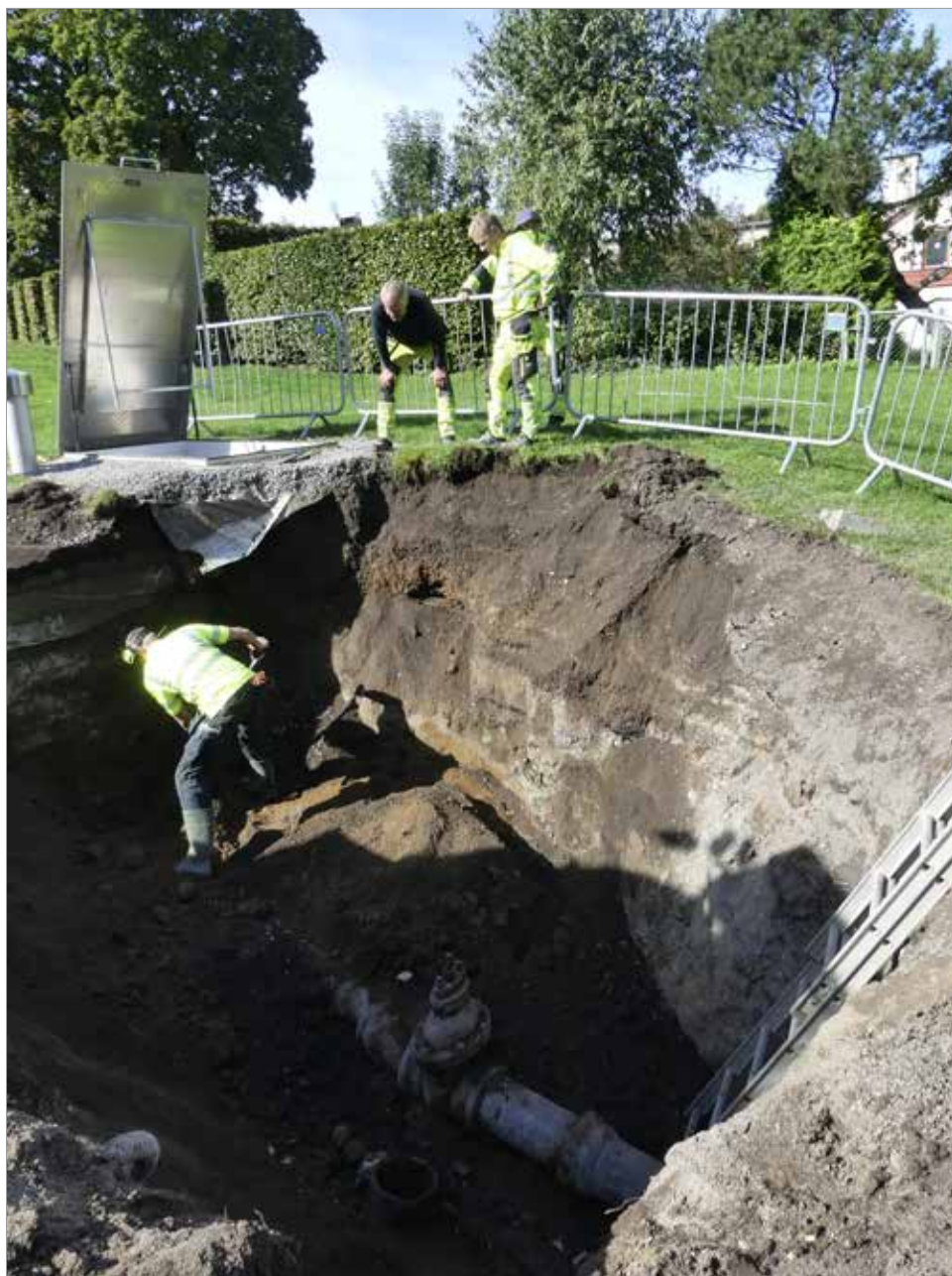
Figur 3. Schaktet i Klosterparken med den dokumenterade schaktväggen, se sektion. I förgrunden syns den trasiga ventilkopplingen.
