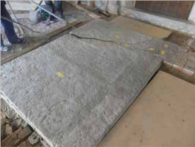
Figur 16 (t.v.). Gravhäll A16 var vid undersökningens början lappad med olika kalkstensbitar. Foto mot SÖ, Karin Stenström.
