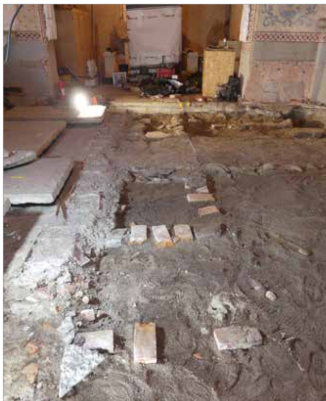
Figur 14. Under nästan samtliga gravhällar fanns utlagda stenar och tegelstenar som stabiliserat gravhällarna. I bild syns även den gjutna källaren och värmekanalerna. Mittgångens gravhällar förvarades under undersökningen på källarens tak. Foto mot Ö, Karin Stenström.
