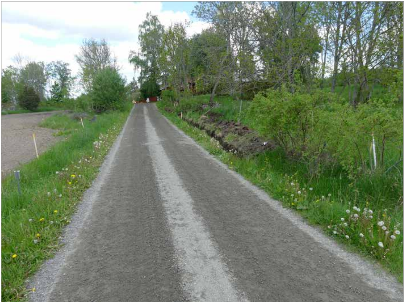
Figur 12. Schaktet inom delsträcka 4 grävdes i dikets bakslänt. I hagen i bakgrunden finns grav- och boplatsoområdet L1941:8600. Foto mot norr, Hans Göthberg, Upplandsmuseet.
