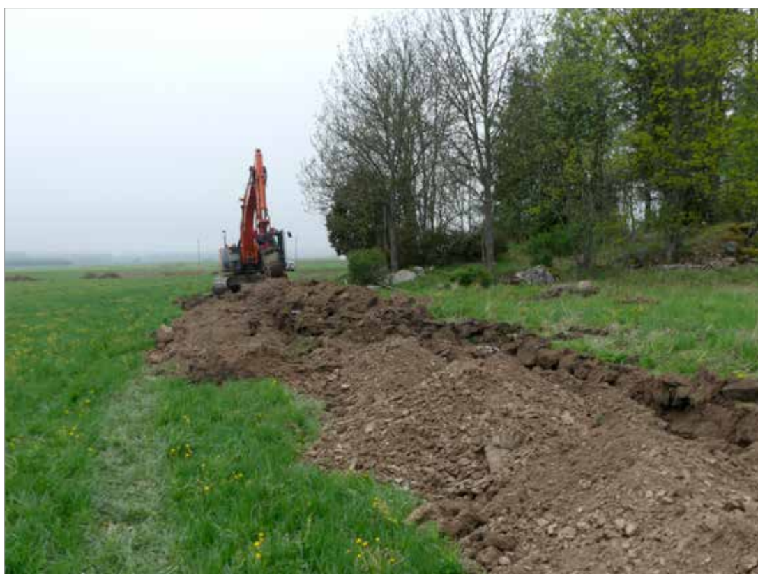
Figur 18. Schaktet där stolphålet påträffades grävdes nära ett impediment, där en skärvtenshög låg. Foto mot väster, Hans Göthberg, Upplandsmuseet.
