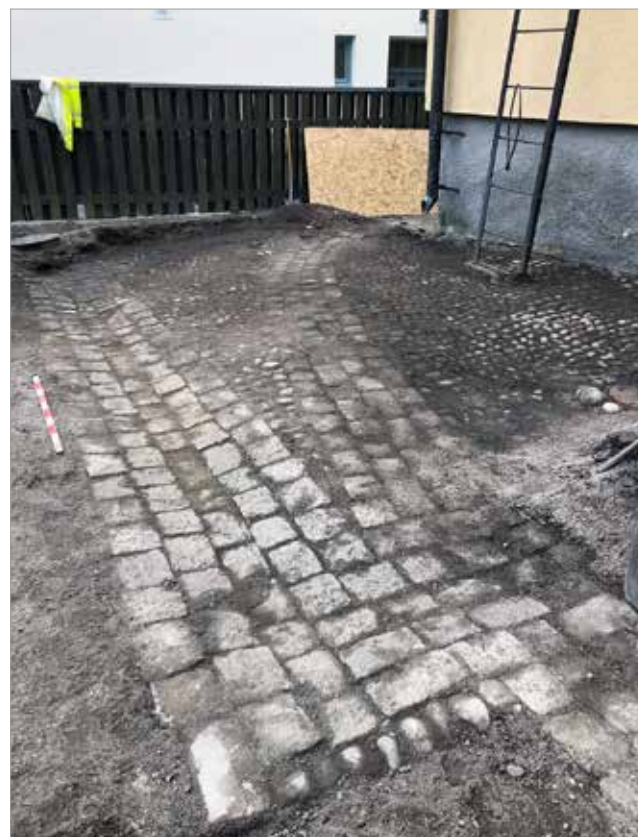
Figur 19. Stenläggning A7, A8 och A9 som utgjordes av partier med storgatsten och kullersten. Troligen lagd i slutet av 1700-talet. Foto mot sydväst, Anna Ölund Upplandsmuseet.
