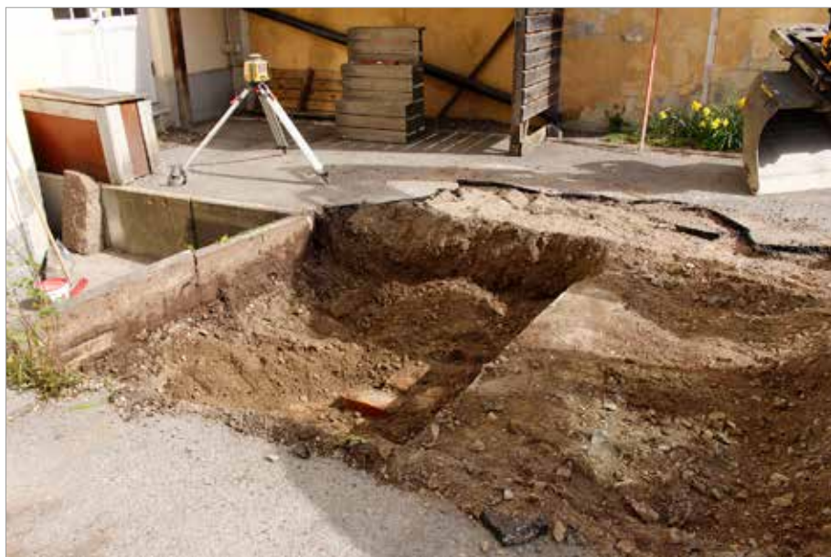
Figur 13. Schaktning inom delyta A. Längst till vänster i bild syns den nedsänkta delen av innergården närmast hotellets fasad och den betongmur A2 som omgärdar den nedsänkta ytan. Till höger om den nedschaktade ytan anas raseringslagret A5 efter ytterligare en betongmur A3. Foto mot NÖ, Anna Ölund, Upplandsmuseet.
