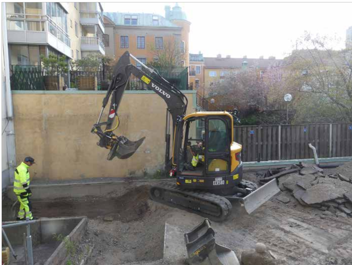
Figur 2. Schaktningsarbete inom delyta A på undersökningsområdets norra del med innergårdarna i kvarteret Bryggaren i bakgrunden. Foto mot öster, Anna Ölund Upplandsmuseet.
