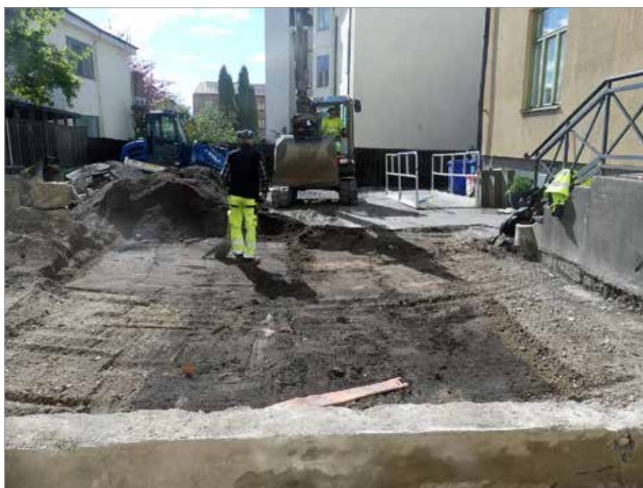
Figur 14. Avbaning mellan delyta B, utschaktat parti, och delyta D med bevarade kulturlager (i bildens mitt). I förgrunden syns betongmur A3. Foto mot söder, Anna Ölund, Upplandsmuseet.
