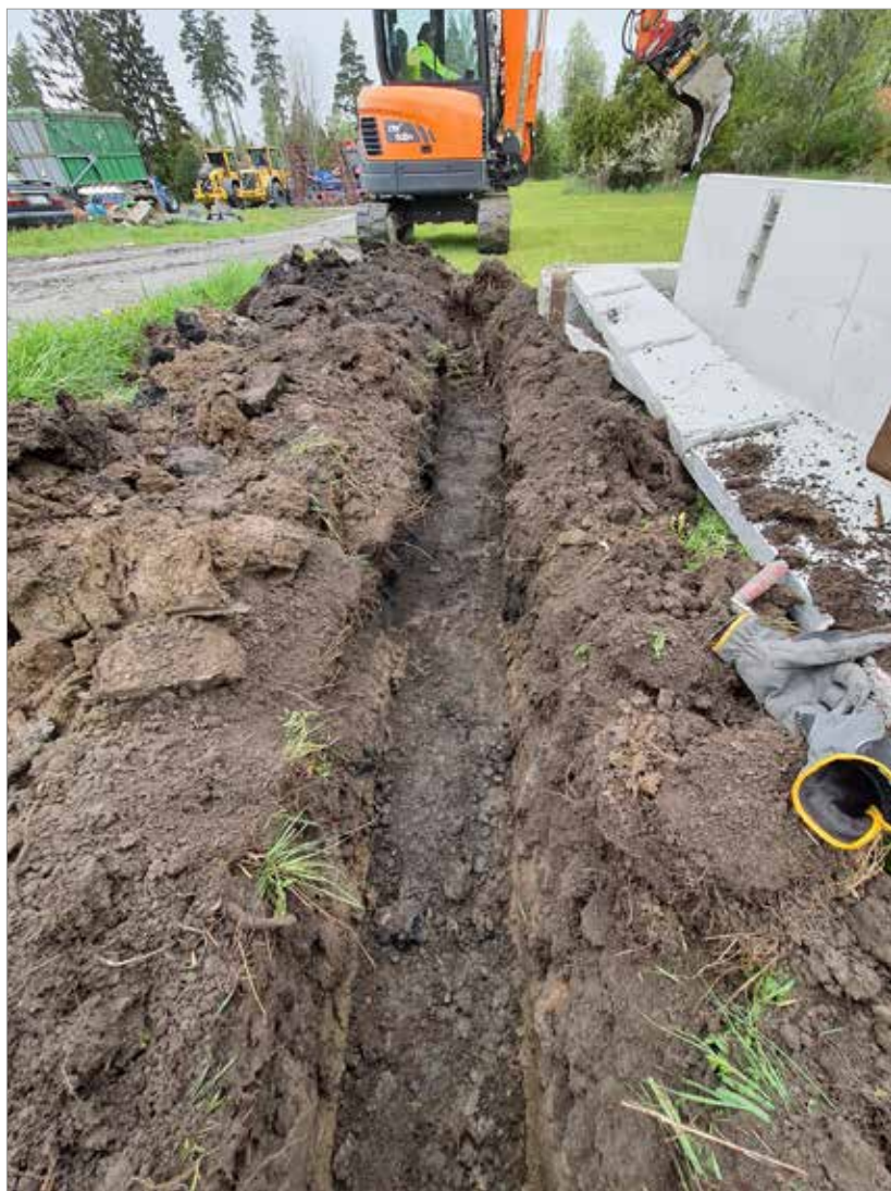
Figur 49. Kulturlager 1910 i norra delen av schakt 2025. Foto fr. S: Per Frölund.
