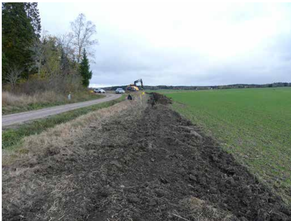
Figur 17. Schaktet vid Vrå under arbete. Foto fr. SÖ: Hans Göthberg.
