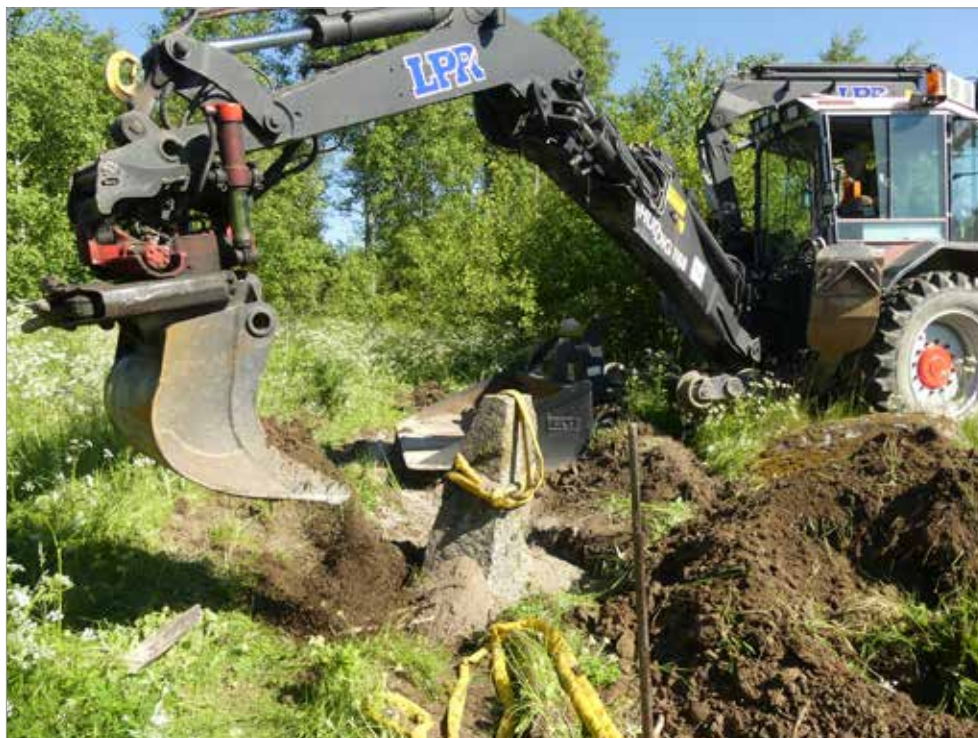
Figur 5. Markförankring av stenen sedan den lyfts på plats. Foto mot norr, Robin Lucas, Upplandsmuseet.
