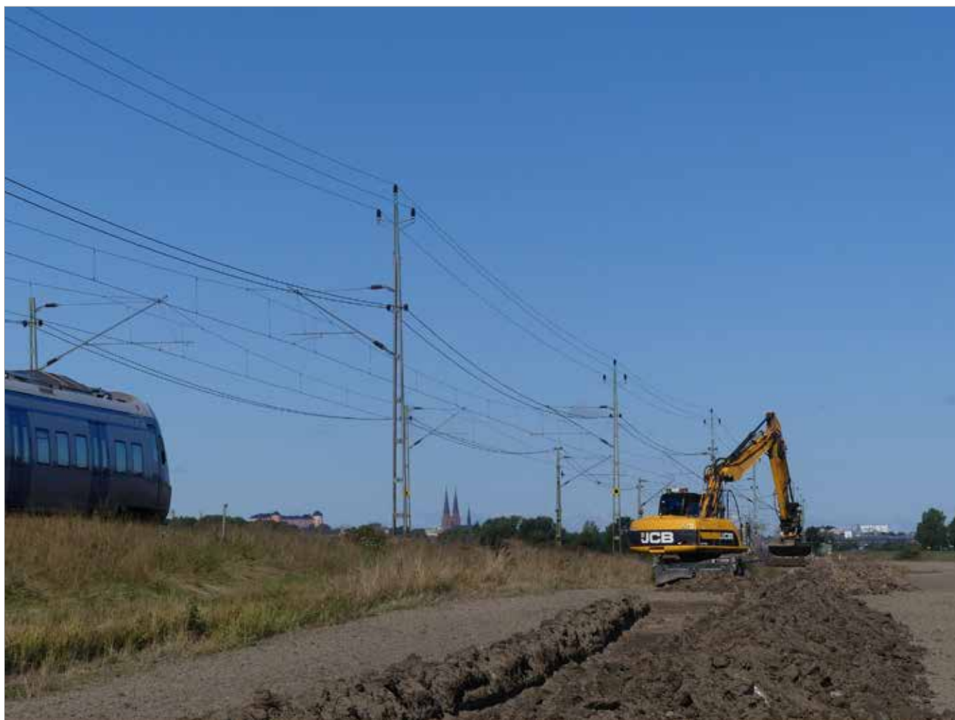
Figur 4. Igenläggning av sökschakt på Lokal 18. Foto Malin Lucas, Upplandsmuseet.
