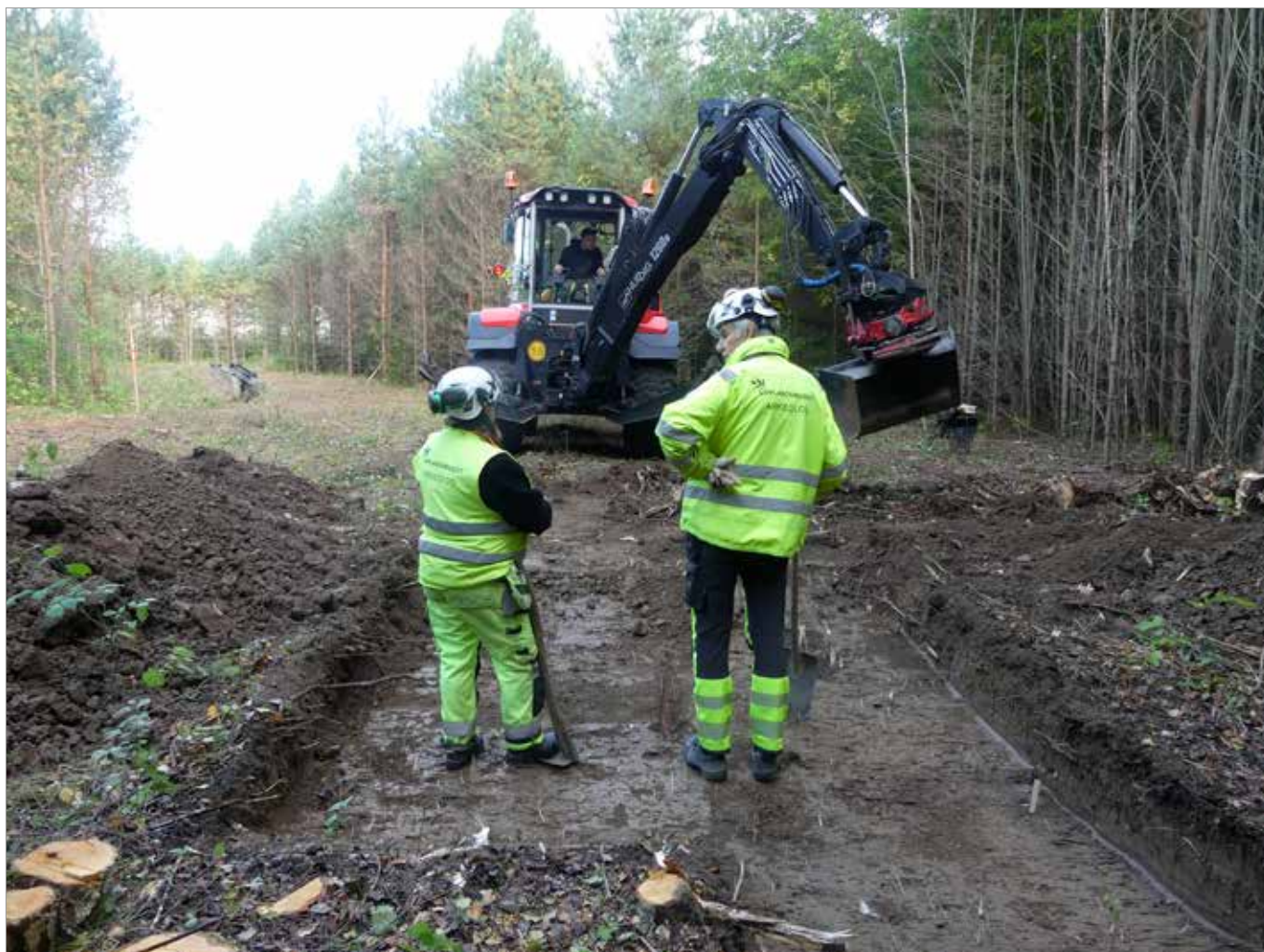
Figur 8. Schaktningen skedde inom de ytor och smalare stråk som hade avverkats inför förundersökningar. I och kring schakten fanns talrika stubbar och rötter, som dock vanligen inte hade trängt ned under matjordslagret. Här visas schakt 1 i den sydöstra delen. Foto mot nordväst, Ebba Drugge, Upplandsmuseet.
