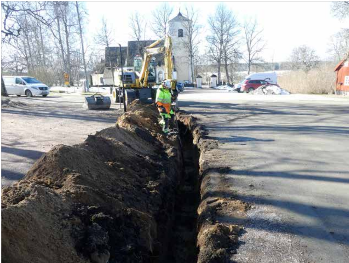
Figur 8. Den norra delen av schaktet vid Lenaberg grävdes på åsens krön. Lena kyrka i bakgrunden. Foto mot söder, Hans Göthberg, Upplandsmuseet.
