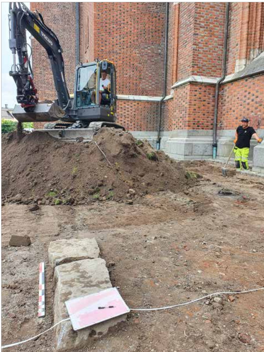
Figur 2. Arbetsbild visande schakt 1, kontext K1:2. Foto mot öster, Adam Hultberg, Upplandsmuseet.
