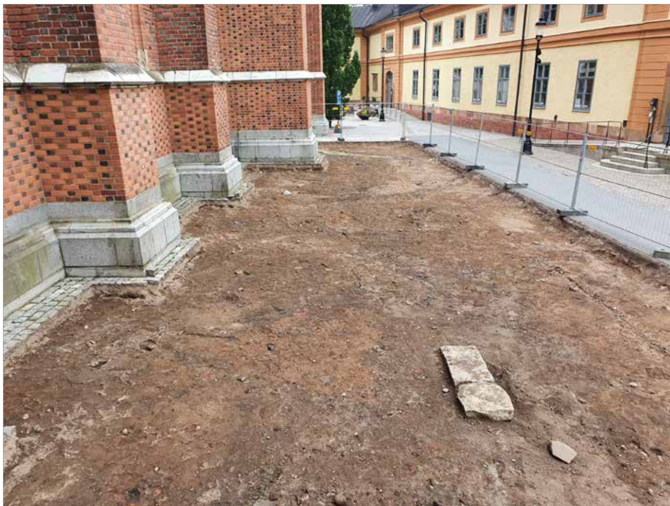
Figur 6. Översiktsfoto visande den västra delen av schakt 1 samt stenblocken, K1:2. Foto mot väster, Adam Hultberg, Upplandsmuseet.
