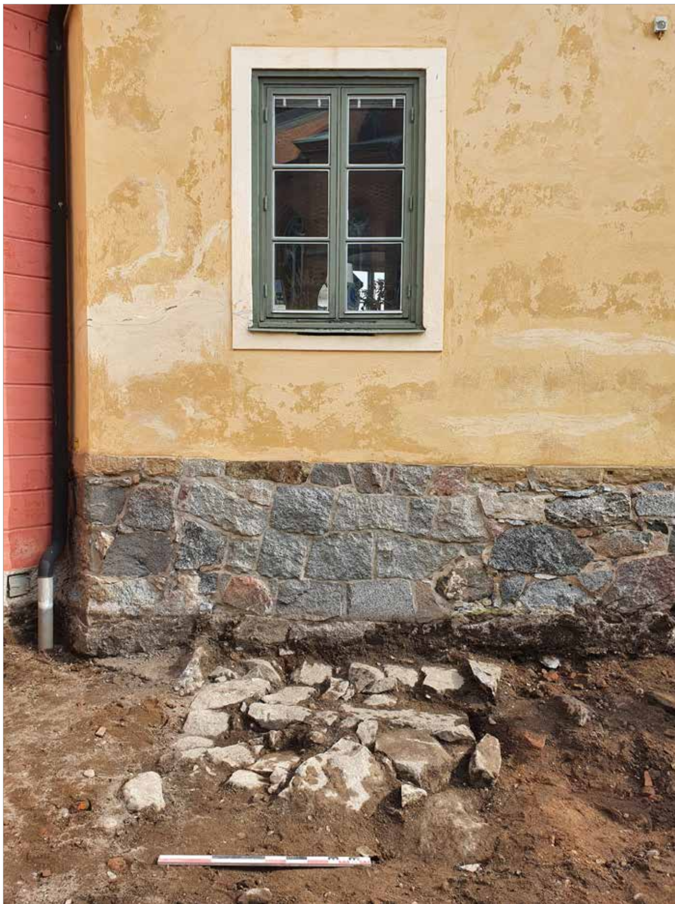
Figur 16. Fotografi visande stenkonstruktionen K6:1 – ett trappfundament, intill domkapitelhusets fasad. Notera det avvikande materialet i murverket direkt ovan. Foto mot nordöst, Adam Hultberg, Upplandsmuseet.
