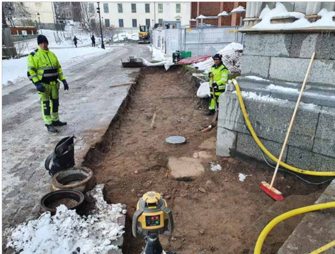
Figur 14. Arbetsfoto visande stenar i schaktbotten, under domkyrkans sydportal. Foto mot väster, Adam Hultberg, Upplandsmuseet.
