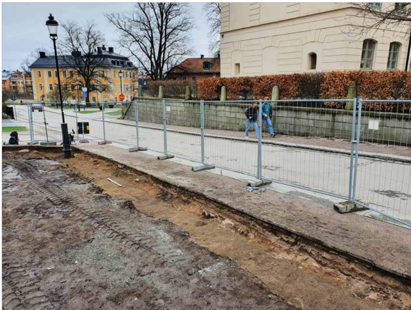
Figur 21. Under trottoarkanten syns raseringslagret K7:1. Foto mot sydöst, Adam Hultberg, Upplandsmuseet.
