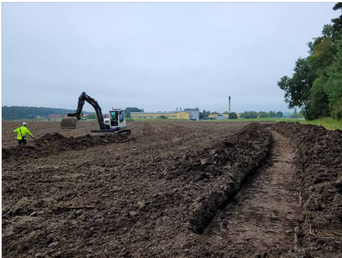
Figur 15. Lokal 9 utgjordes av nyplöjd åker. Inga lämningar påträffades i schakten. I bakgrunden syns byggnader i Ultuna. Foto mot söder, Robin Lucas, Upplandsmuseet.
