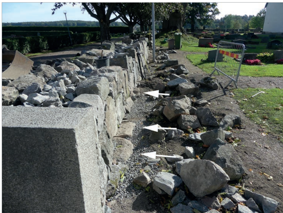
Figur 7. Delar av en äldre murkonstruktion ligger kvar under den nylagda muren. Foto mot öster, Robin Lucas, Upplandsmuseet.
