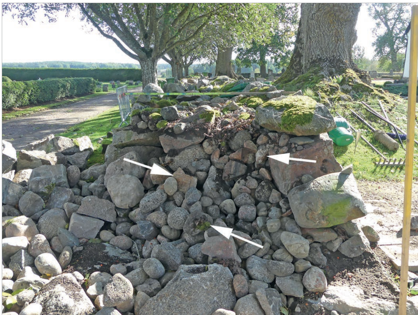
Figur 6. Tvärsnitt genom skalmuren, med större tuktade stenar ytterst och huvudsakligen rundat åsmaterial i mitten. Pilarna indikerar stenar med rester av bruk. Foto mot öster, Robin Lucas, Upplandsmuseet.
