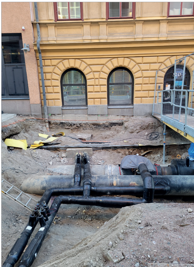
Figur 6. Färdignedlagda rör i Dragarbrunnsgatan strax sydväst om Bangårdsgatan. Foto mot nordost, Malin Lucas, Upplandsmuseet.
