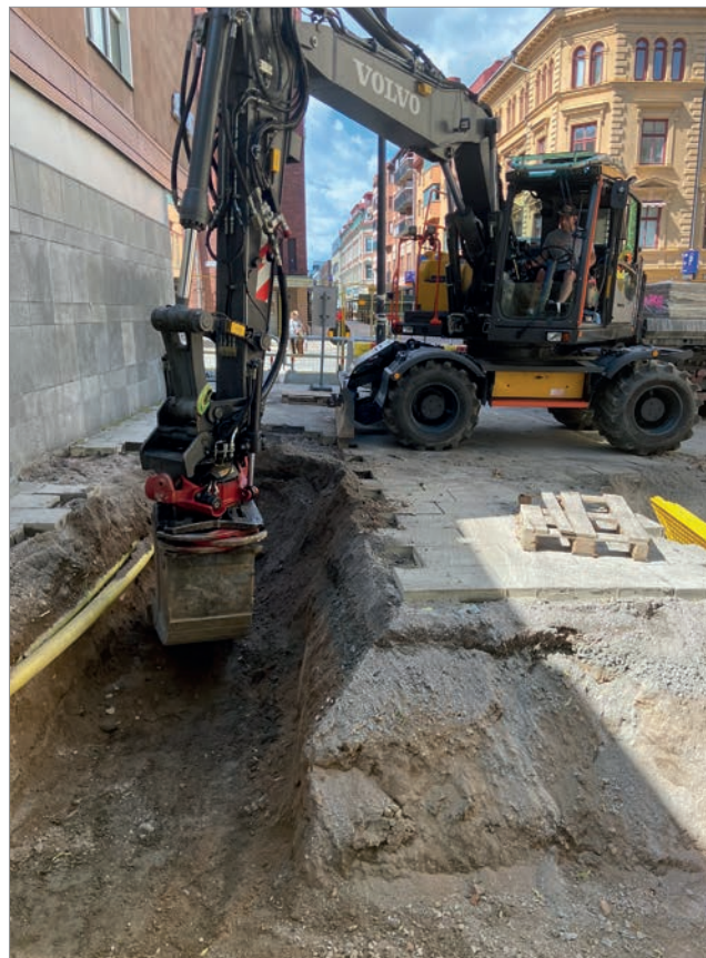
Figur 7. Läget för servisschakt längs fasad. Schaktet var det enda där lämningar framkom. Foto mot nordväst, Anna Ölund, Upplandsmuseet.
