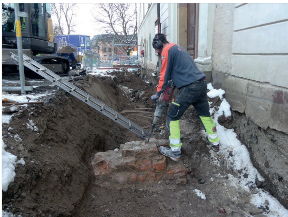
Figur 42. Murresten rivs ner till schaktbotten. Foto mot norr, Robin Lucas, Upplandsmuseet.
