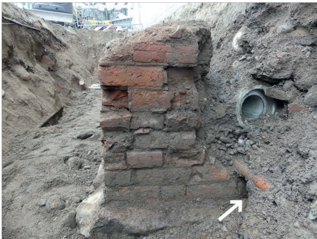
Figur 36. Muren framrensad. Pilen visar var muren fortsätter in under dräneringschaktet (objekt 51) och vidare in under Gustavianums västra yttermur. Foto mot norr, Robin Lucas, Upplandsmuseet
