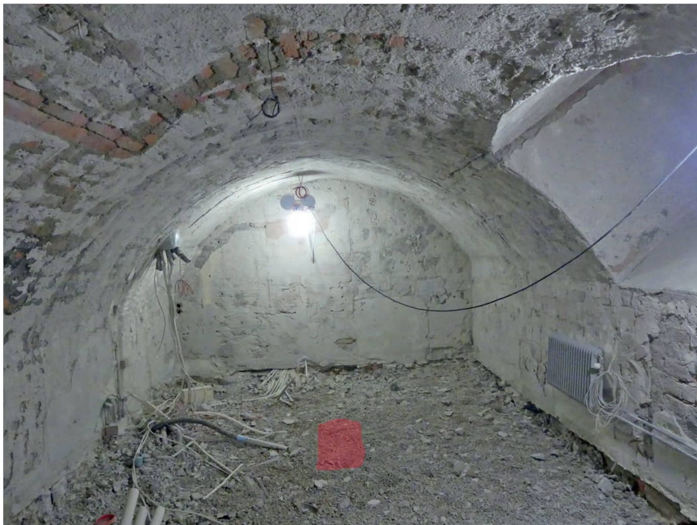
Figur 30. Schakt E. Läget för provgröp markerat. Foto mot söder, Robin Lucas.
