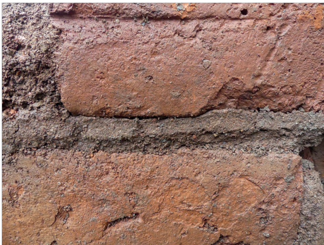
Figur 37. Detalj av murningen, med högkvalitativt kalkbruk lagt i åsfog med två faser Foto, Robin Lucas, Upplandsmuseet
