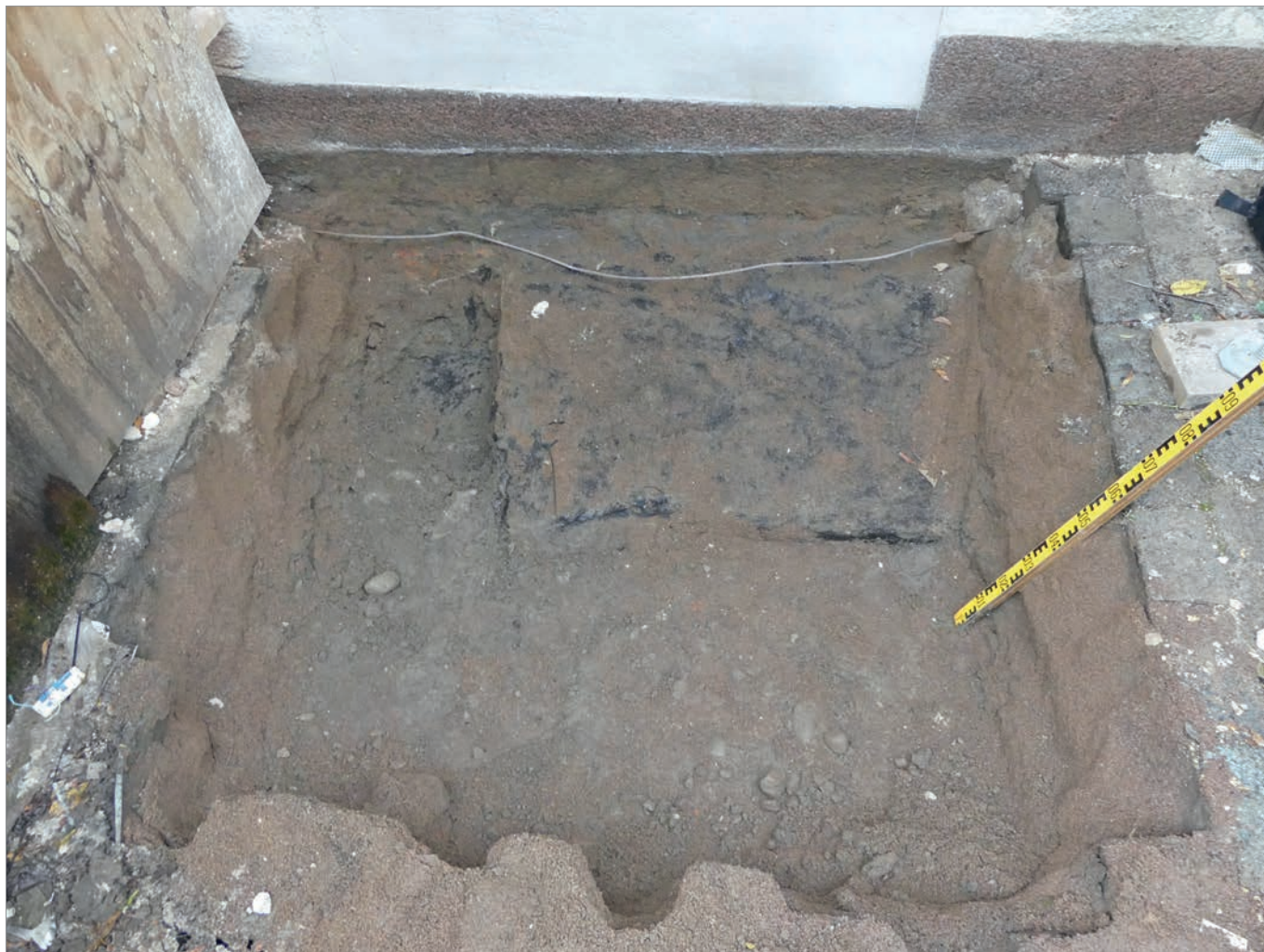
Figur 44. Schakt H. Den tjärade grundmuren synlig i bildens överkant. Foto mot öster, Robin Lucas, Upplandsmuseet.
