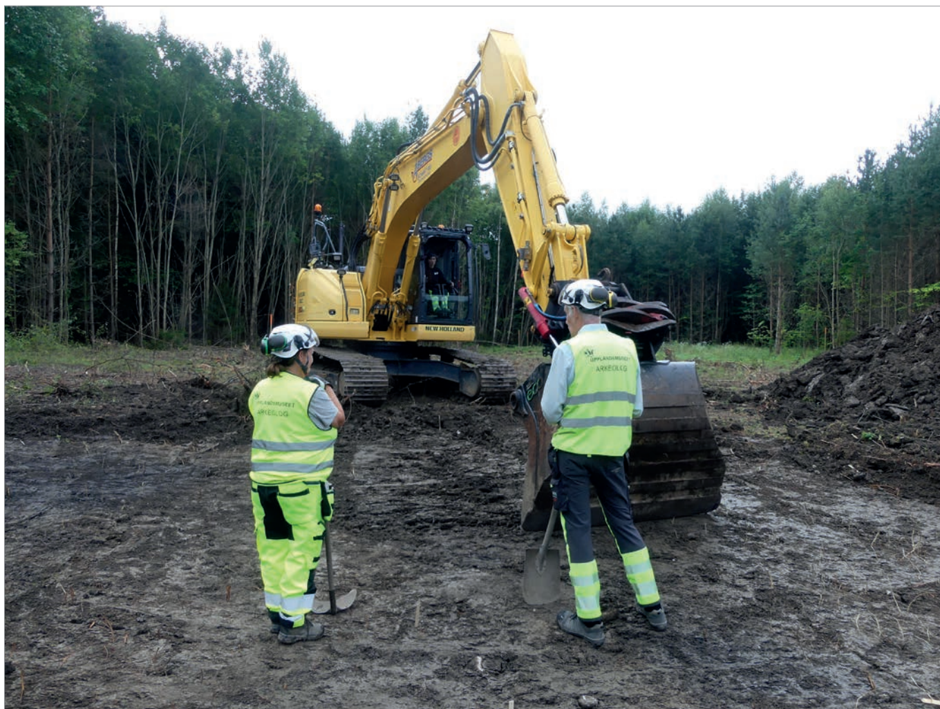
Figur 3. Borttagningen av matjord gjordes med en grävmaskin som dirigerades av arkeologer. Foto mot sydöst, Andreas Hennius, Upplandsmuseet.
